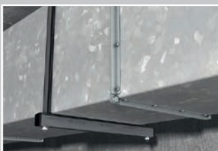
Легкая монтажная шина FLS, прокладка EMS 31
